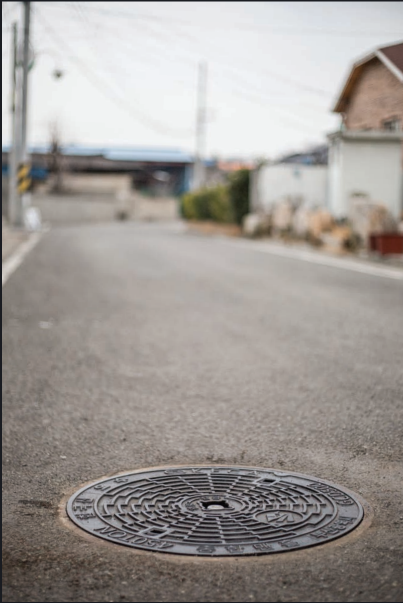
교체시공 완료 현장
